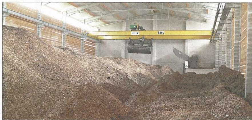
Die Hackschnitzel werden mit einem automatischen Ladekran manipuliert. Er lagert frisch angeliefertes Material ein, schichtet die Hackschnitzel um und beschickt den Fülltrichter (rechts hinten), aus dem der Kessel versorgt wird (hinter der Brandschutzmauer).
