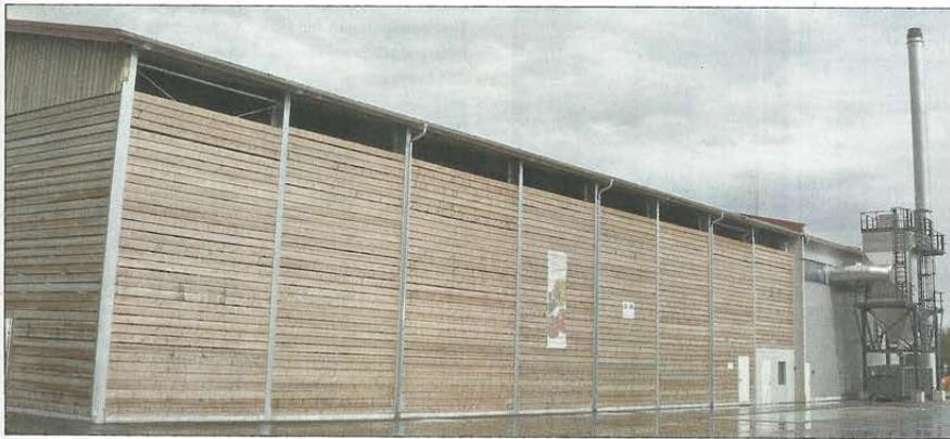
In der 60 m langen mit Holz beplankten Halle befinden sich das Kesselhaus (rechts) und der Brennstoffbunker.
