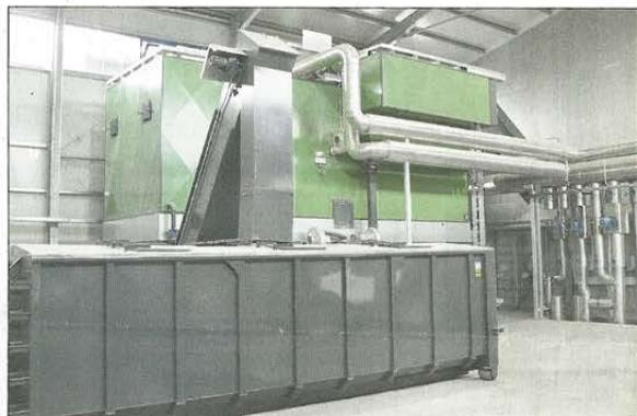
Der Kessel wird automatisch entascht (Vordergrund). Er ist für ein breites Brennstoffspektrum ausgelegt.
